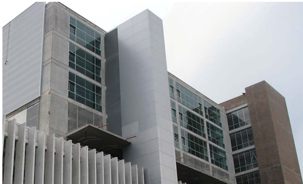
Bloque de Ingenierías [Bl. 19]
